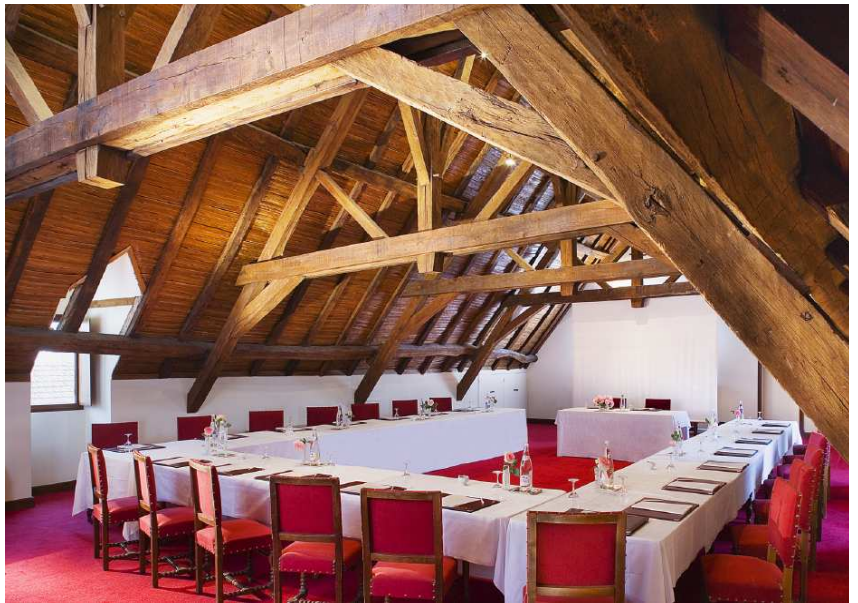
Salle Guillaume de Vienne - 138 m 2
